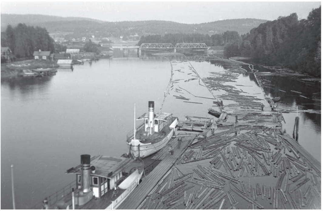
Timmerflottnig på Österdalälven. Foto: Stormats Axel Olsson
